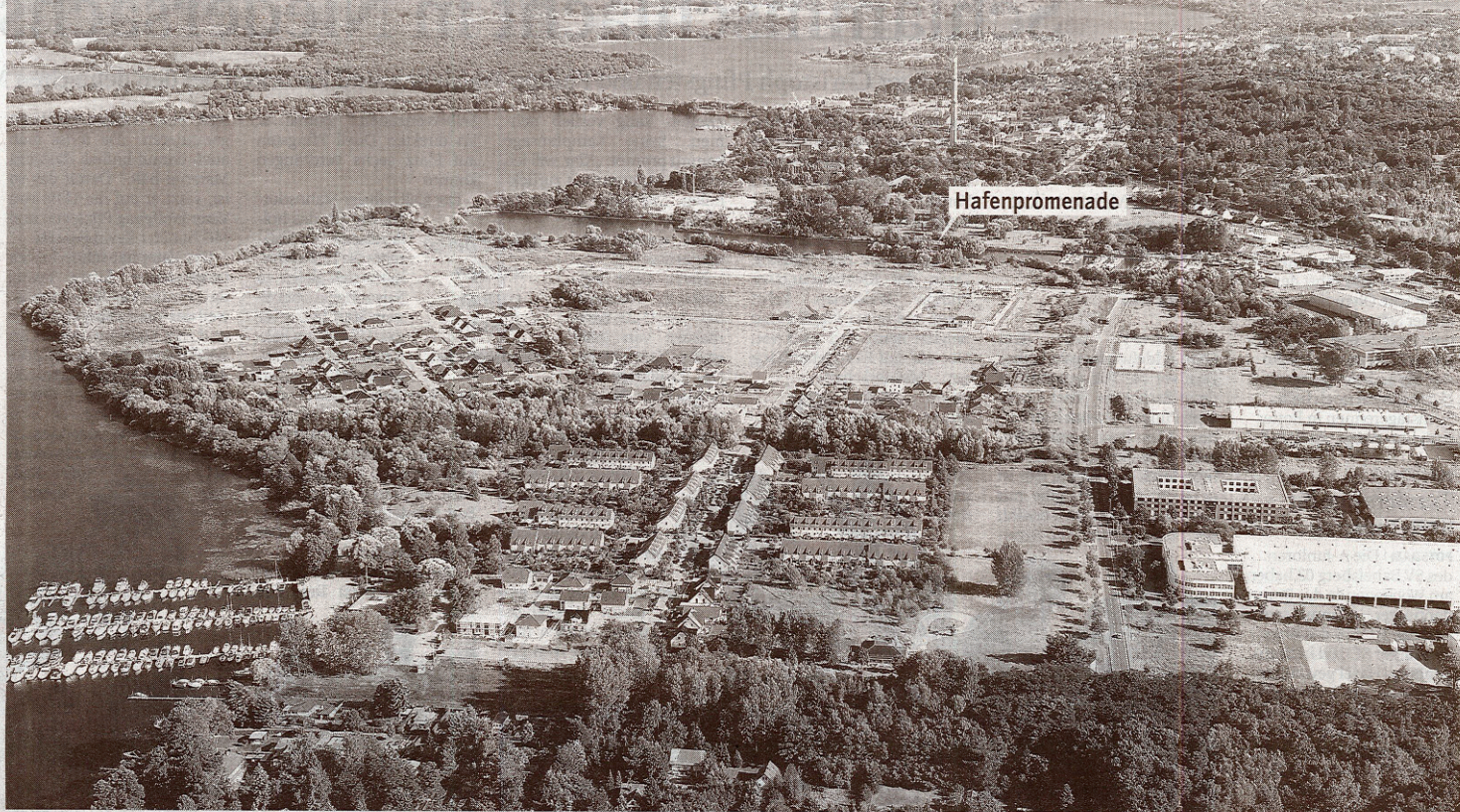
In den Havelauen entsteht neben weiteren neuen Häusern ab April die erste Hafenpromenade für Werder. Sie soll einen Stadtplatz erhalten, an dem 150 Wohnungen gebaut werden.
